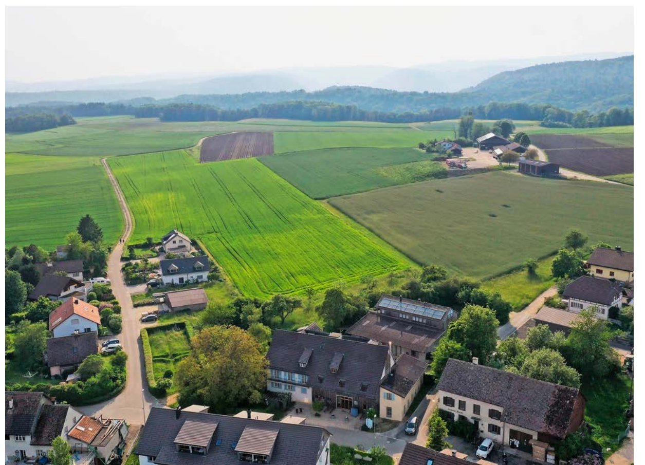
Die Schöpfe musste aus energietechnischen Gründen rückgebaut werden.
