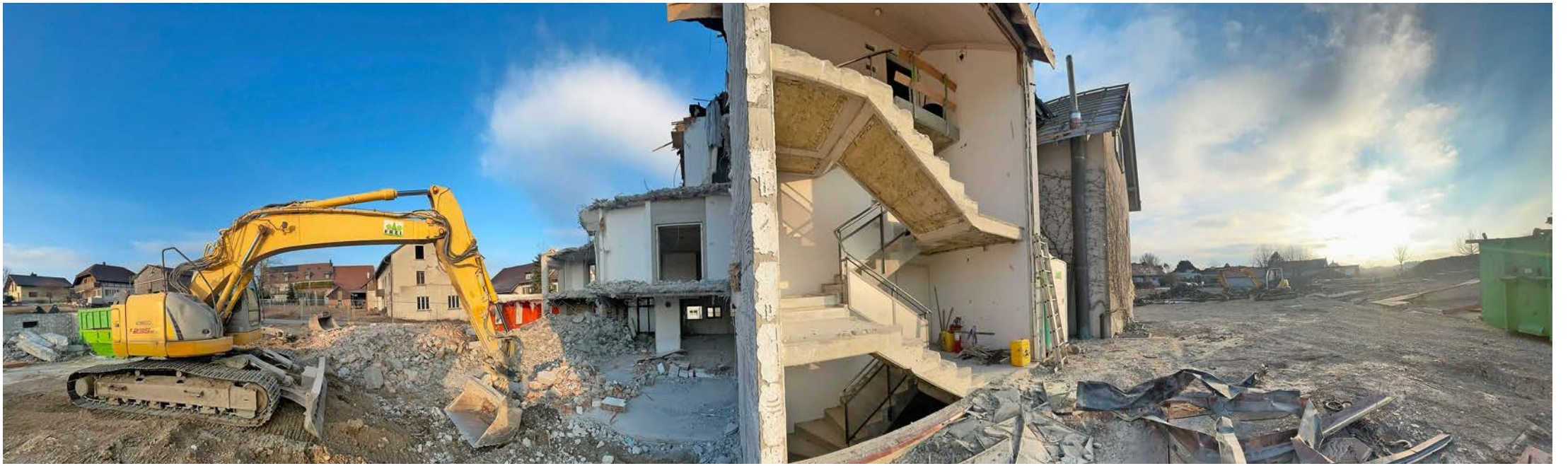
Die Bagger schaffen Platz für ein Neubauprojekt auf dem Schöpfereal in Bütttenhardt. Das Material aus dem Rückbau wird aufgearbeitet und teilweise im Neubau wiederverwendet.
