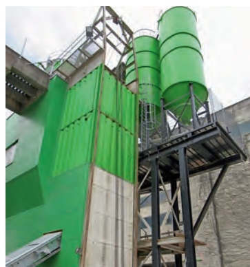
In der eigenen Betonanlage wird Beton unterschiedlicher Qualität hergestellt. Bilder: gb
