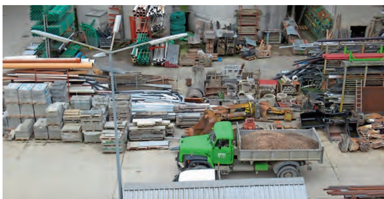
Abbruchmaterial liegt für einen neuen Verwendungszweck bereit.
